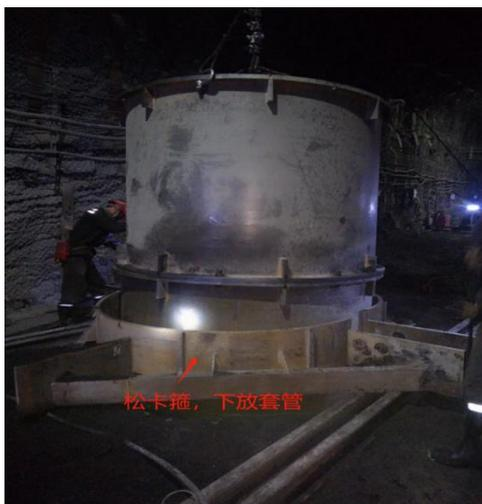
图 8 松卡箍下放套管
