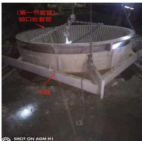
图6 卡箍固定下放套管
