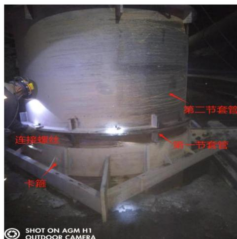
图7 连接套管螺丝
